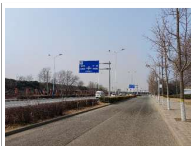
北地块南侧的清源西路（镜向西）
