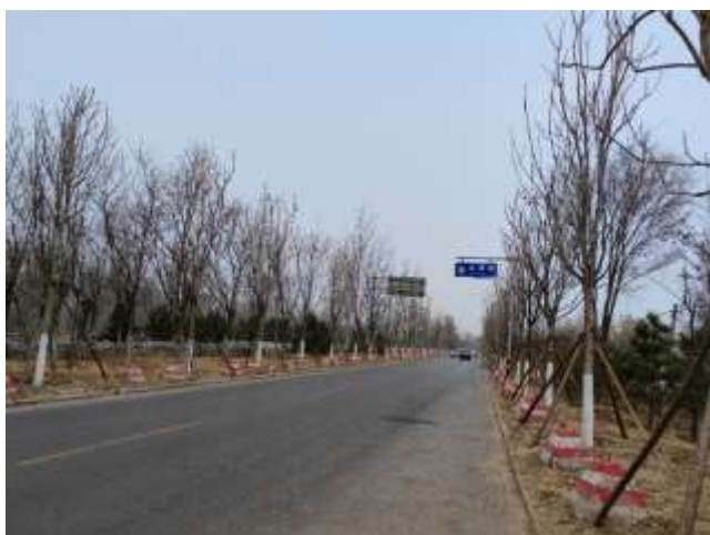
永定河左堤路（镜向北）
