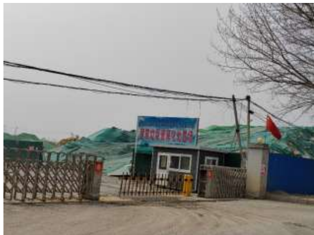
兴建恒福建筑垃圾资源化处置场（镜向西南）
