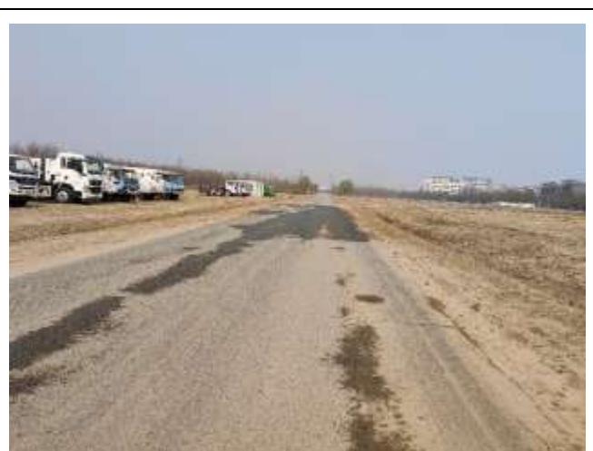
北地块西侧的内部道路（镜向北）
