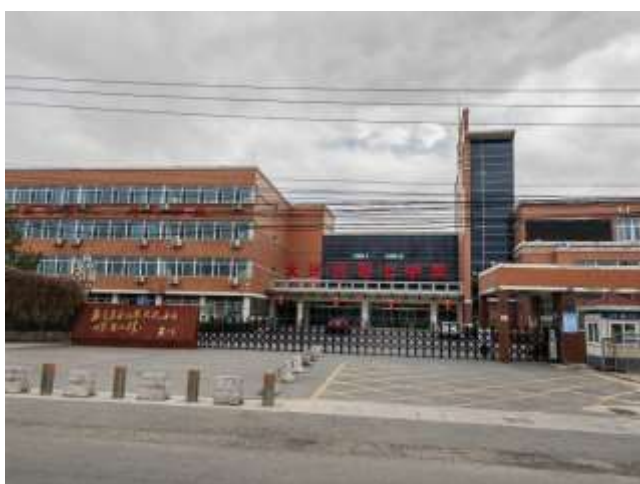
大兴区第七中学（镜向南）
