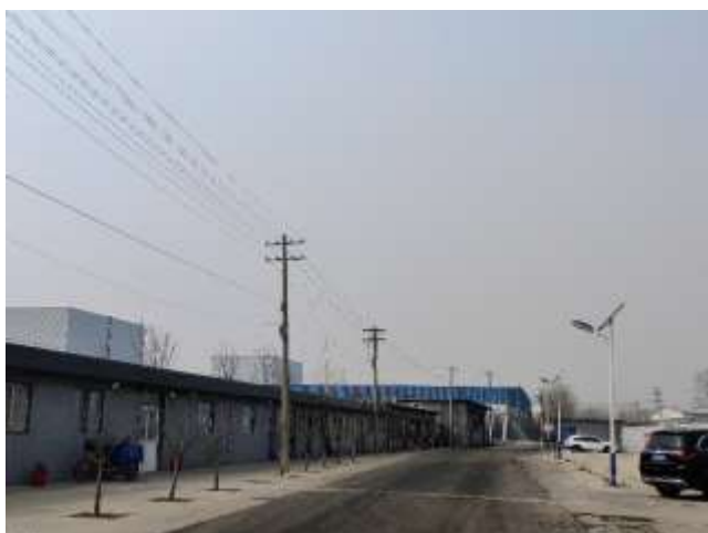
南地块内的黄村镇西片区生活垃圾转运点（镜向西）
