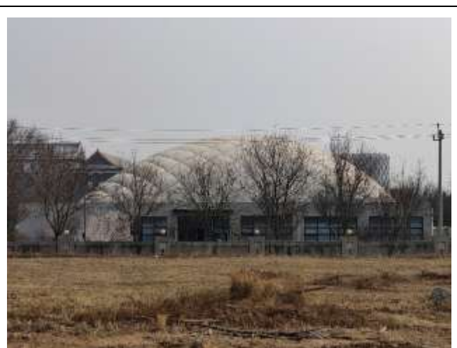
北地块东侧的北京建筑大学运动馆（镜向东）
