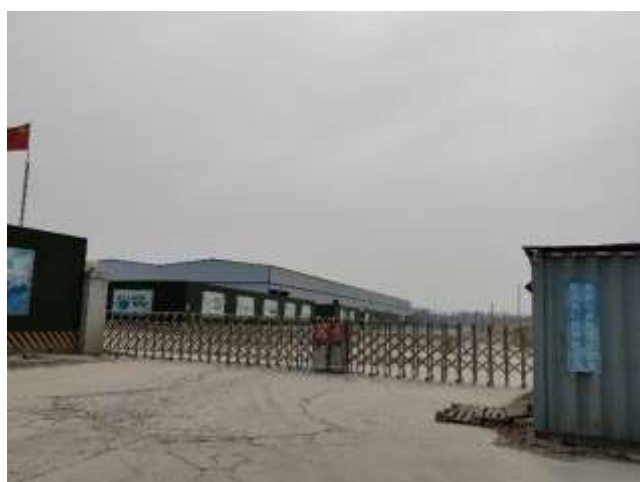
兴建恒福资源循环利用科技公司（镜向东南）
